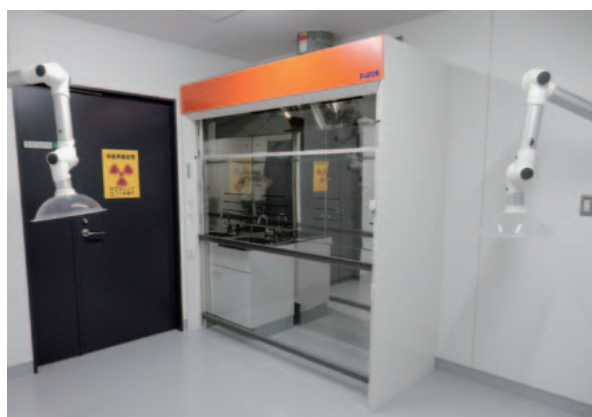
写真 6 局所排気設備を備えた保管廃棄作業室
