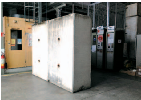
図 8 設置されたコンクリート遮蔽壁
