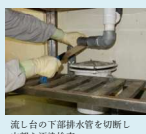
流し台下の下部排水管を切断し、内部を汚染検査
