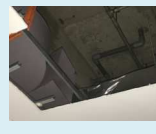
天井裏排気ダクトの取り出し箇所
